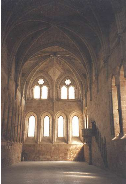
Figura 12 Refeitório do mosteiro de Santa Maria de Huerta, 1144.
